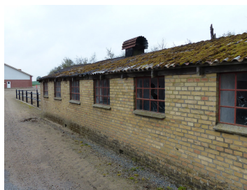
Holdbart murværk med store støbejernsvinduer, som samlet set giver et stort areal til indfald af dagslys.
