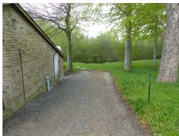
Befæstet areal ved nordgavlen af hønsehuset.
