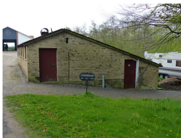
Et grundmuret hønsehus med hulmur og hårdtbrændte teglsten
